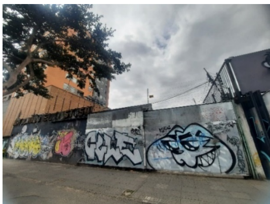
Foto No. 1 Fachada del predio
