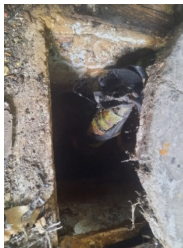
Foto No. 4 Boca del pozo
