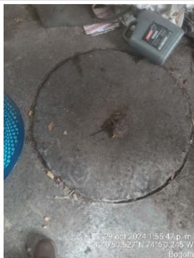
Foto No. 3 Ubicación pozo pz-10-0024
